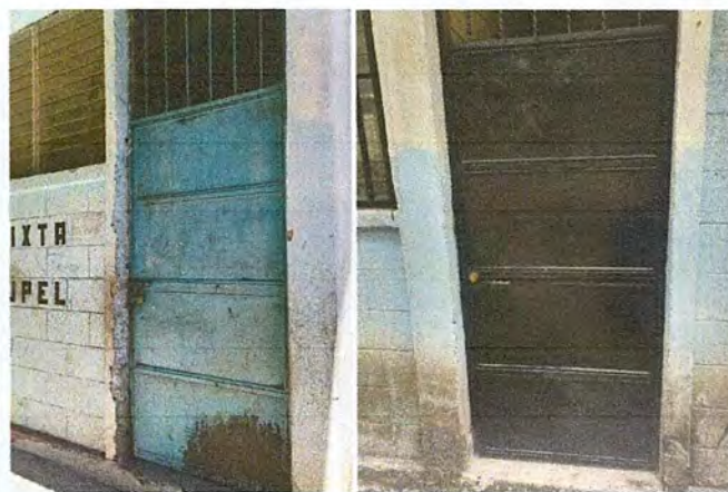
Foto 4: MEJORAMIENTO E INSTALACION DE PUERTAS
